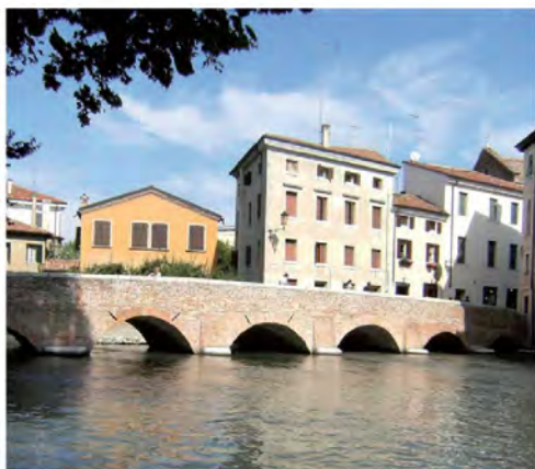
Consolidamento Pilastri - Cucitura Crepe Delle Volte - Armatura Della Soletta Collaborante - 2002
