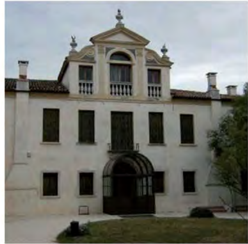
Consolidamento - Tiratura Armata Barriera Chimica - 1989/90 - 2011/12
