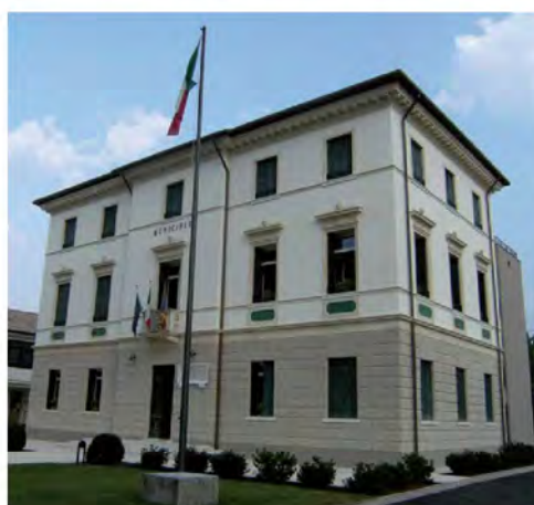
Consolidamento - Tiratura Armata Barriera Chimica - 2007
