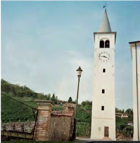
Consolidamento - Carotaggio Armato
