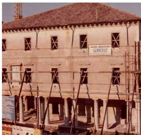
Consolidamento - Barriera Chimica 1986/87
