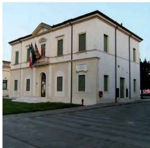
Consolidamento - Barriera Chimica 2003
