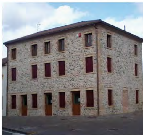
Consolidamento - Barriera Chimica 2012
