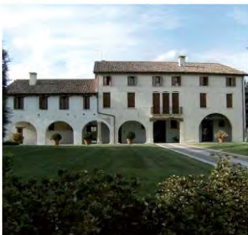
Consolidamento - Tiratura Armata Barriera Chimica - 1994
